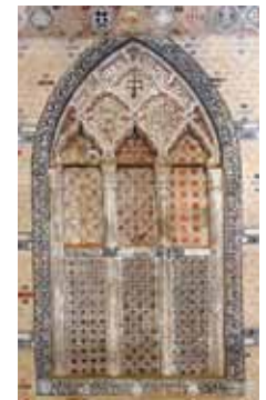
Ventanal con yeserías
