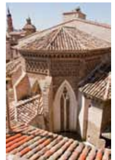
Fachada principal y ábside central de San Pedro de los Francos
