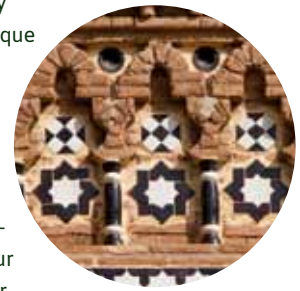
Decoración de la fachada principal de la iglesia de San Martín de Tours
