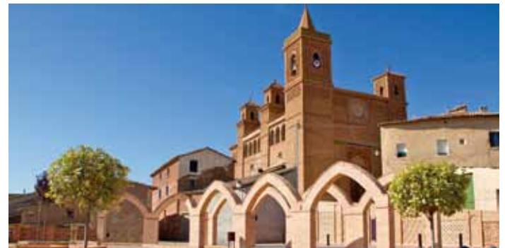
Vista exterior de la iglesia de Torralba de Ribota
