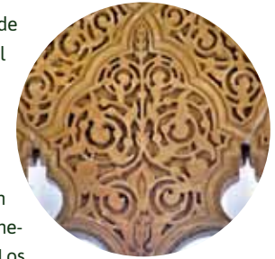
Yeserías del ventanal del presbiterio
