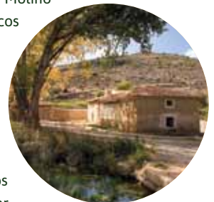
Molino harinero de Cimballa
